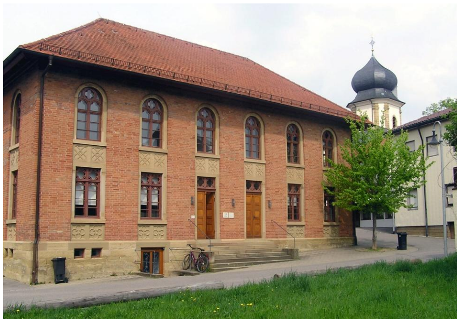
Die Synagoge im Ortskern von Obersulm-Affaltrach. Im Hintergrund der Kirchturm der evangelischen Johanneskirche
