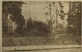
Wo ehemals in der Oberen Freiheitsstraße in Göppingen die Synagoge stand, befindet sich heute ein Schrebergarten.
